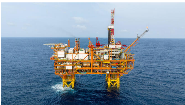
Cette plateforme pétrolière en mer de Chine a été reconvertie en site de stockage de carbone. La China National Offshore Oil Corporation prévoit d'y stocker plus de 1,5 million de tonnes de CO 2 . Située à 200 kilomètres au sud-ouest de Shenzhen, elle injecte le gaz capturé à une profondeur de 800 mètres sous le plancher sous-marin.
